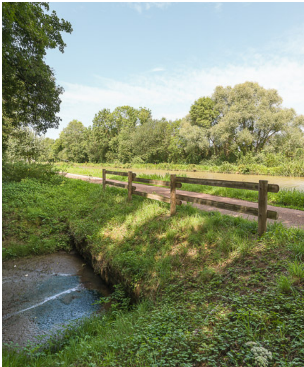
Vue de l'aqueduc.
