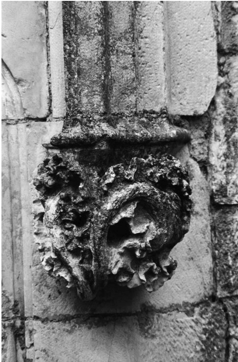
Porte d'une tourelle doublant une tour d'angle. Sculpture décorative : végétaux (photo prise en 1969).
