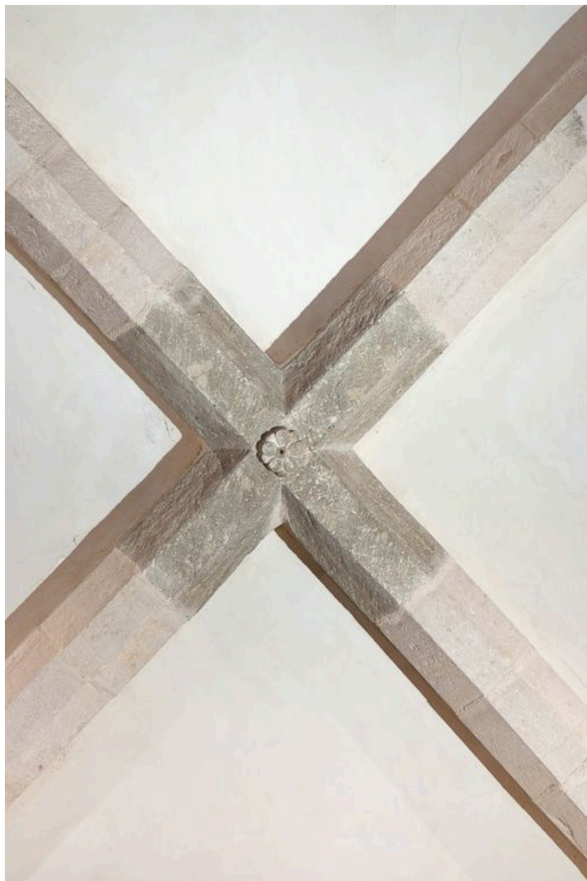
Clef de voûte du choeur.
