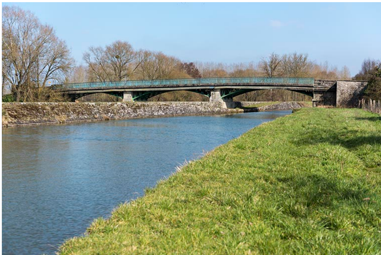
Vue depuis l'aval
