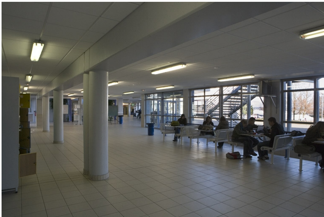
Bâtiment B. Vue du préau couvert.
