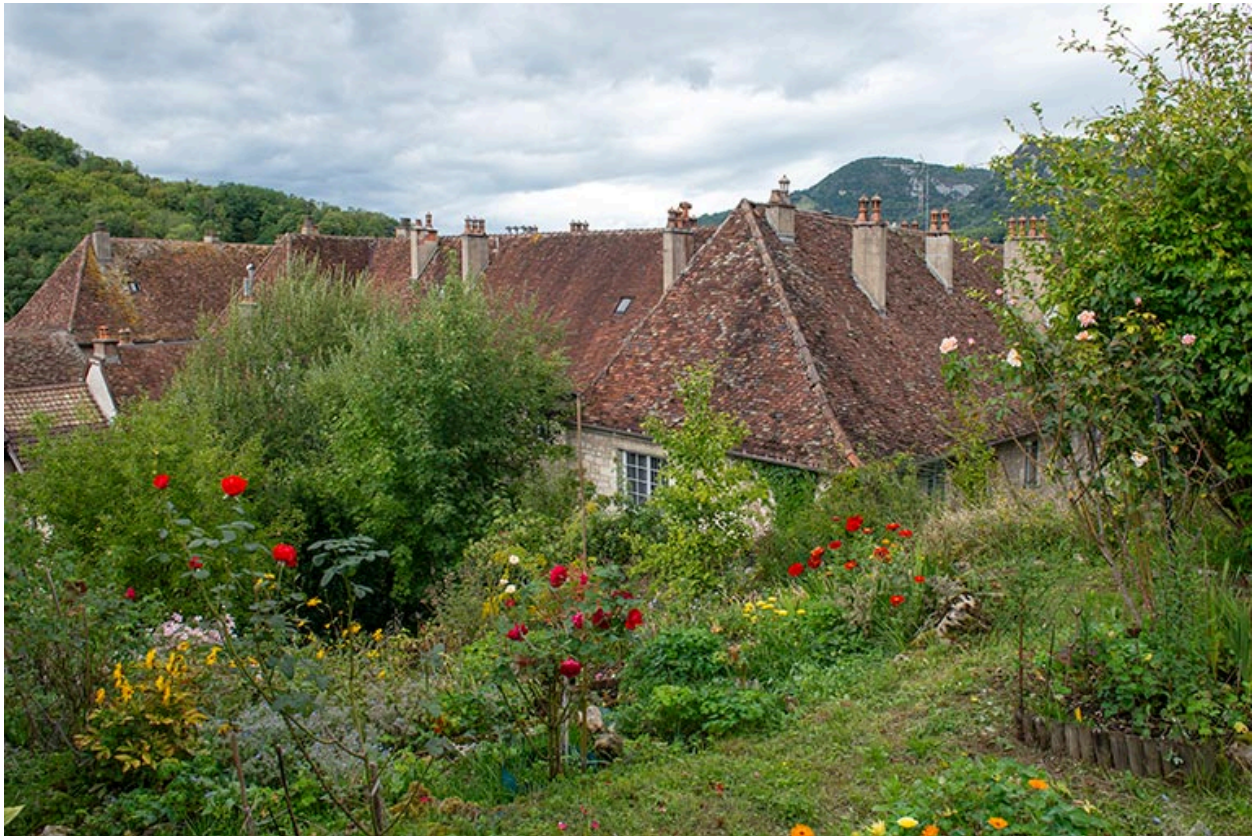
Toitures du couvent, depuis le sud-est.
