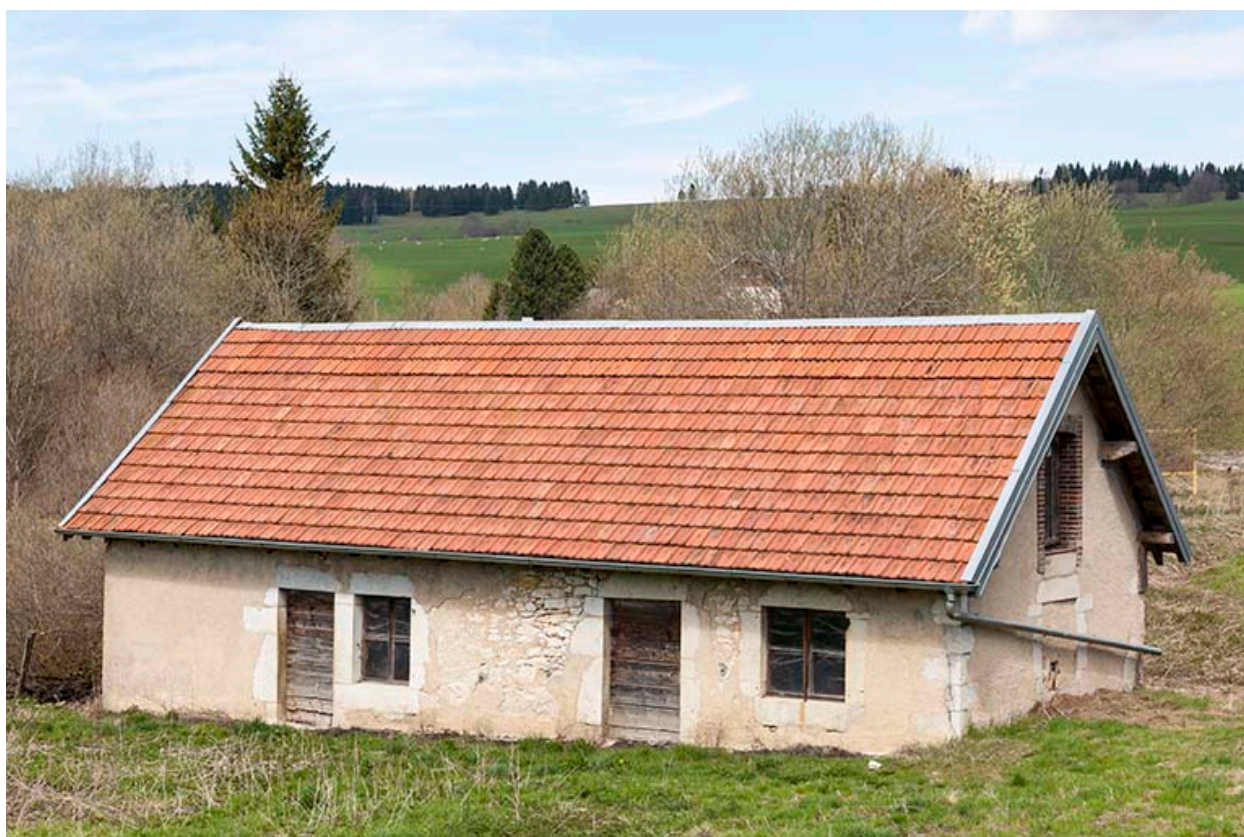
Ancien atelier de forge. Façade sud.
