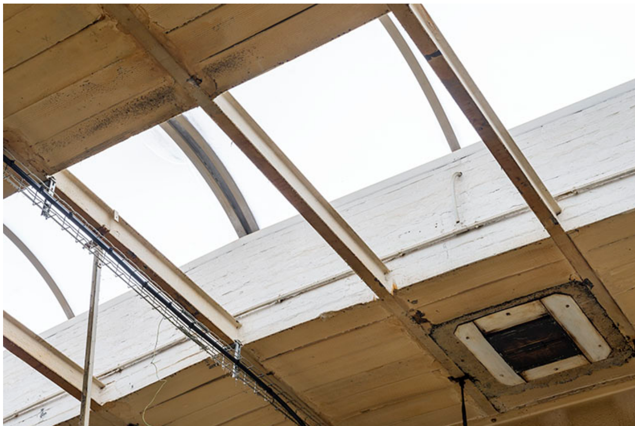
Détail du système d'éclairage zénithal (briques pleines sur ossature métallique).
