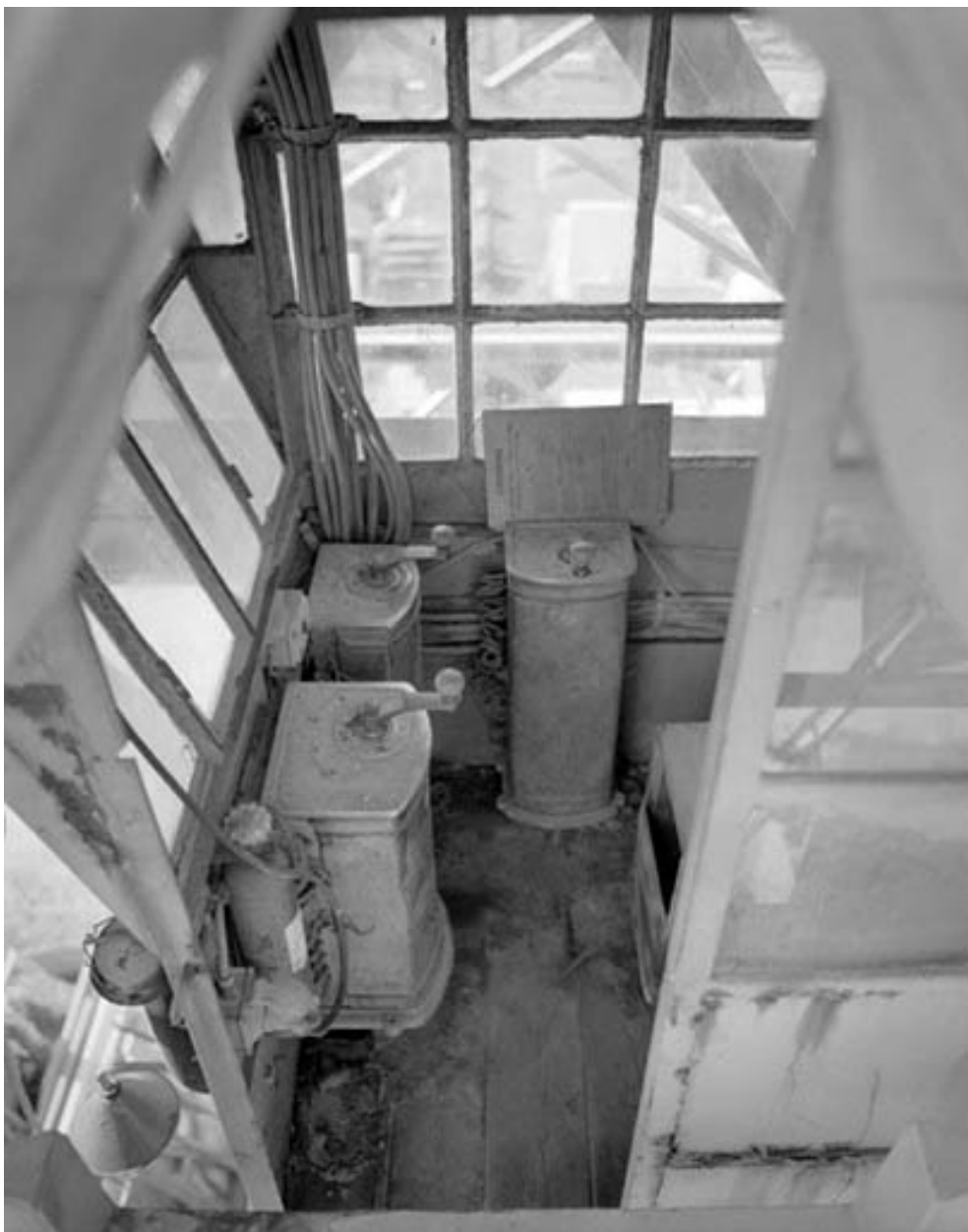
Intérieur de la cabine.
