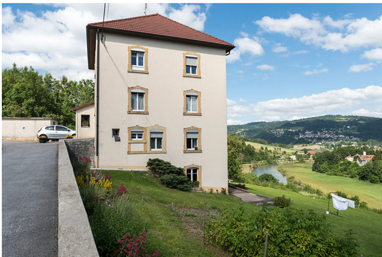
Façade latérale droite.
