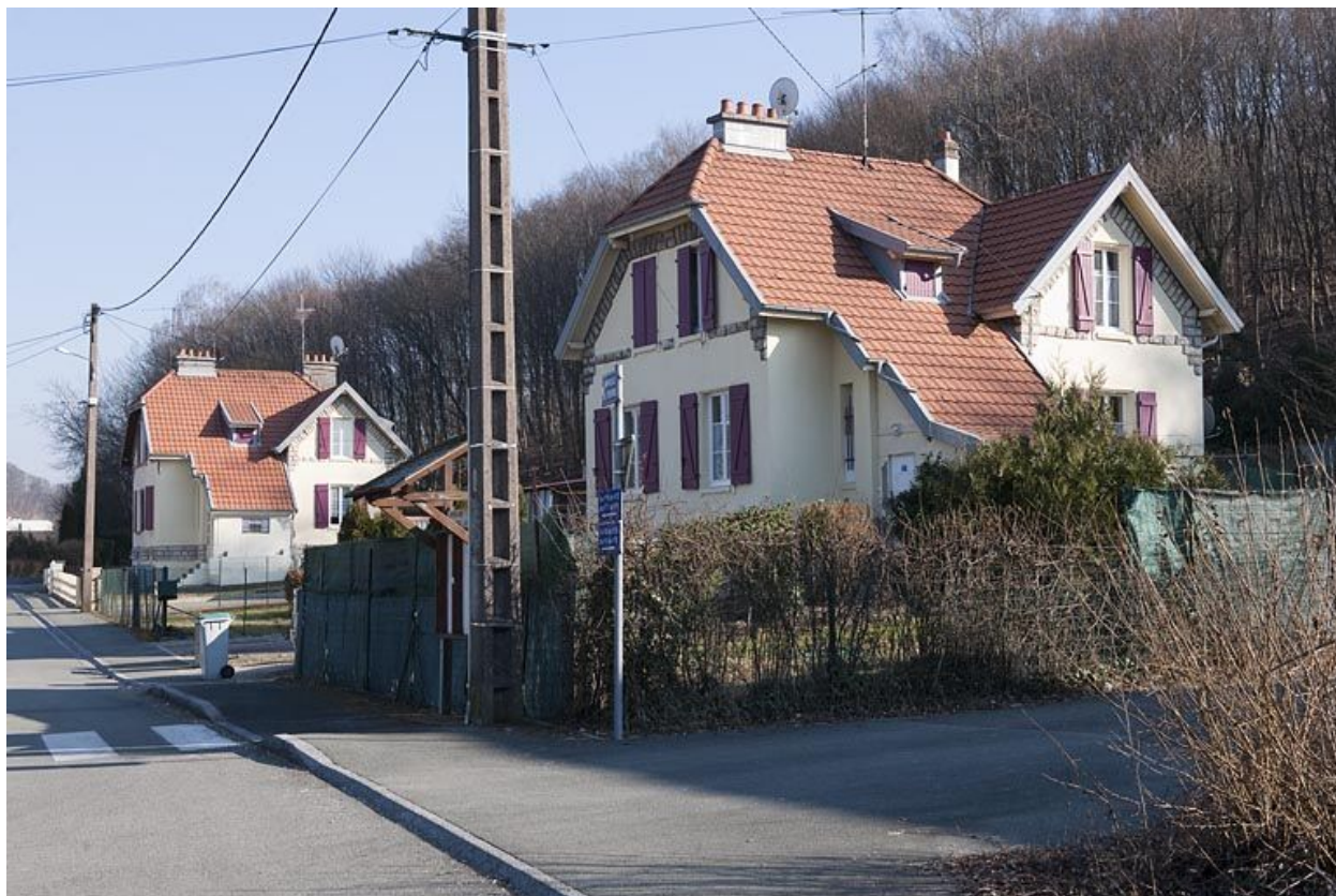
Groupe de 2 maisons jumelées situées à l'est.
