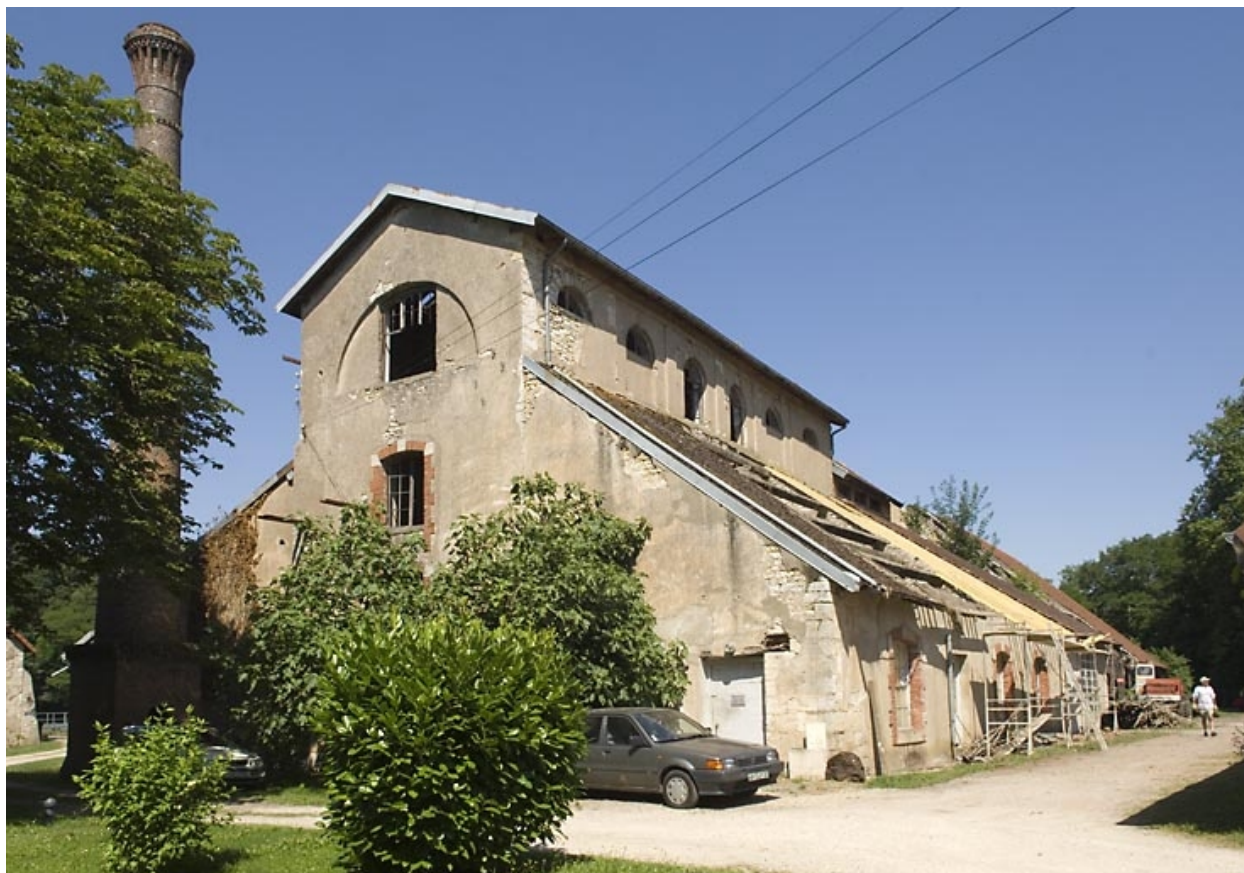
Le haut fourneau vu depuis le sud-est.
