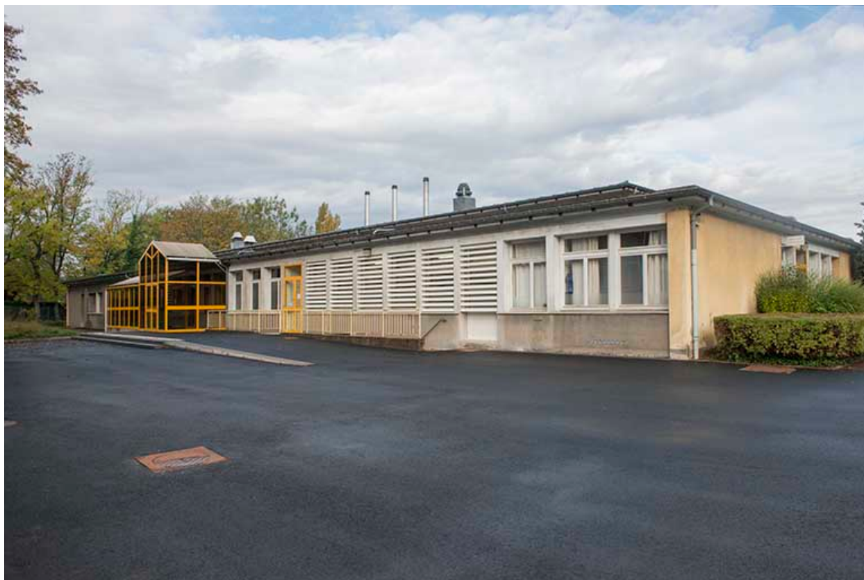
Angle sud-est de la restauration.
