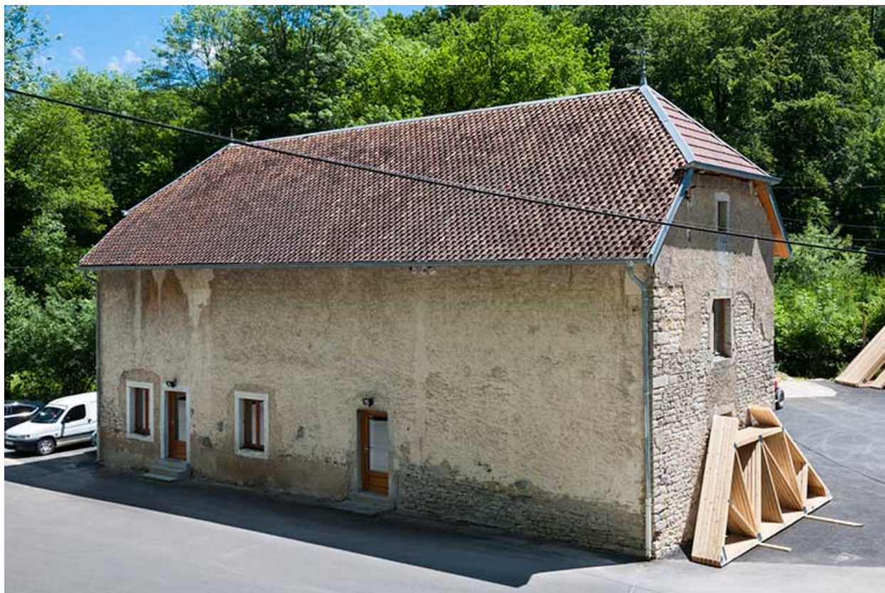
Bâtiment agricole vu de trois quarts.
