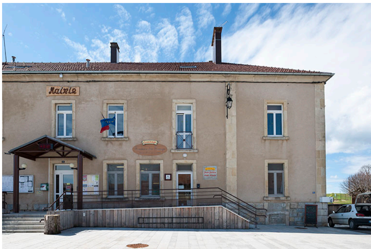
Façade nord (partie fromagerie).
