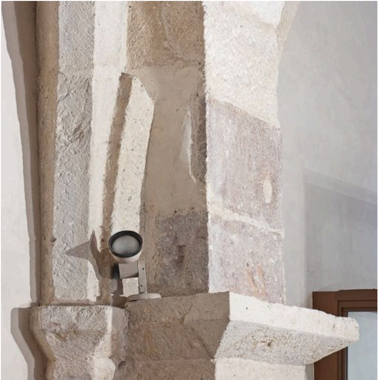
Départ des nervures de l'angle antérieur gauche de la troisième travée du bas-côté droit.
