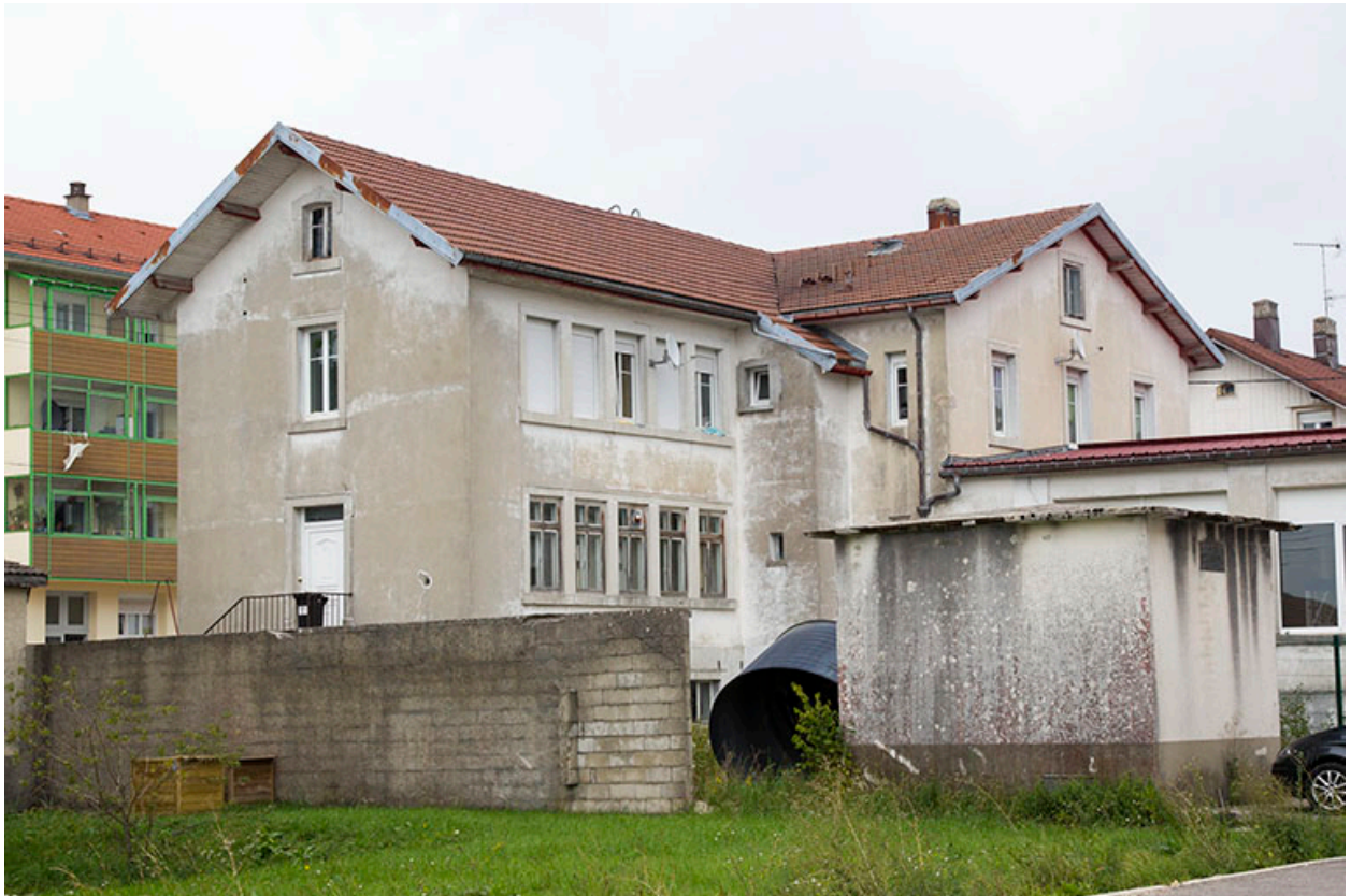
Façades postérieure et latérale droite.
