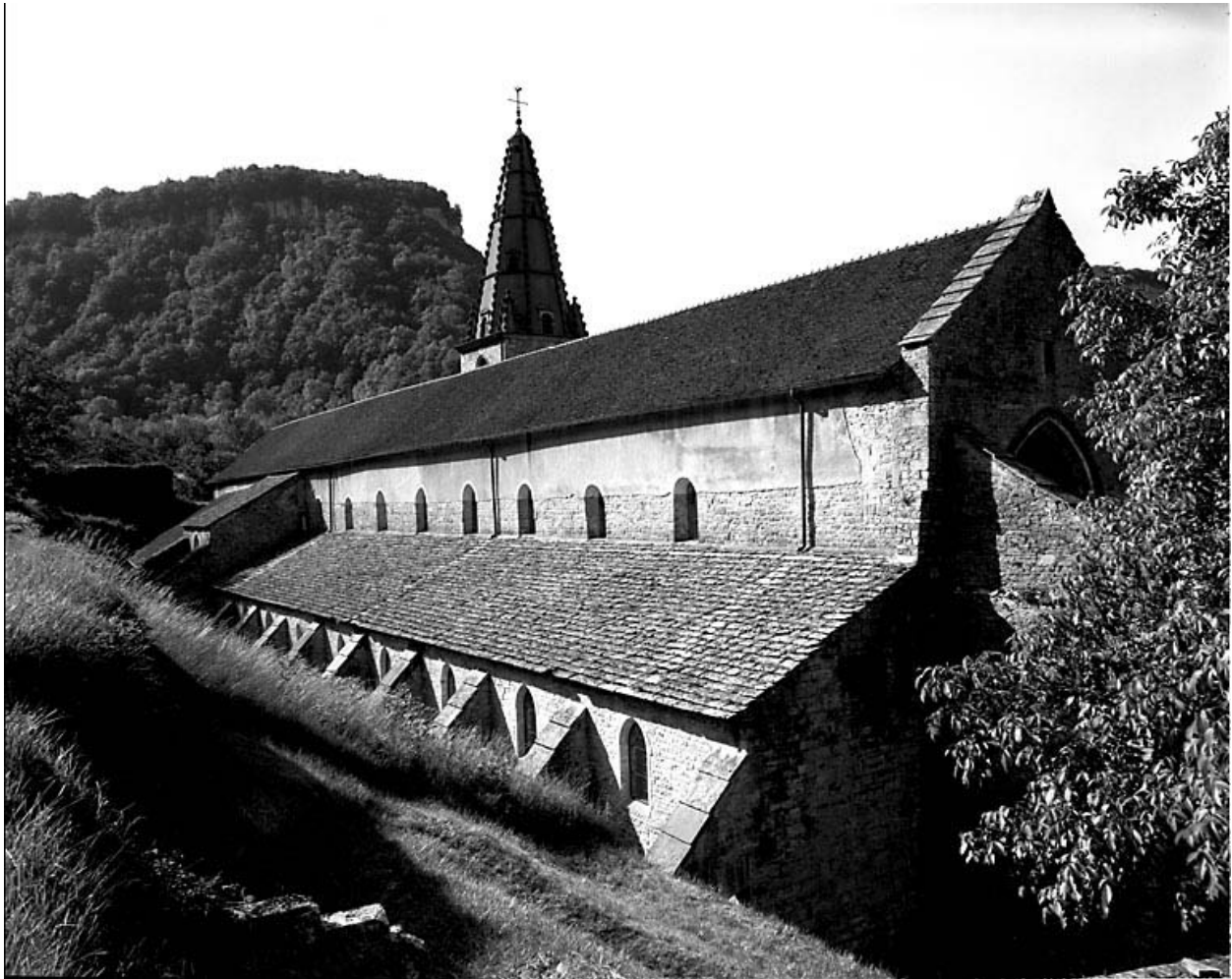
Eglise abbatiale : face nord, vue depuis le nord ouest.
