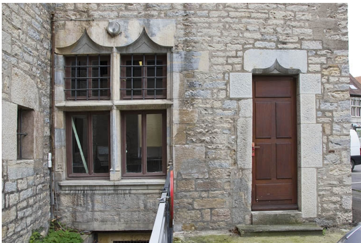
Façade postérieure : détail du rez-de-chaussée.
