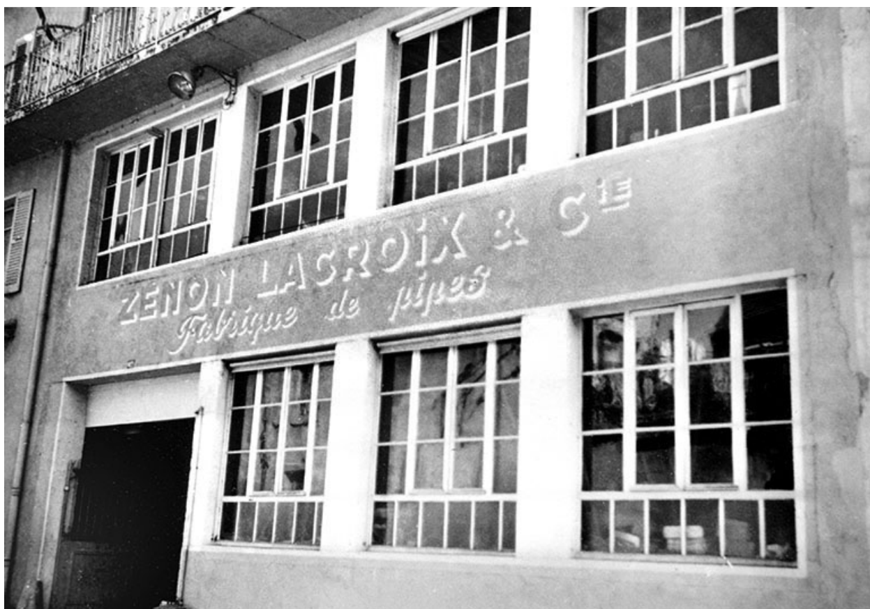
Façade antérieure du n° 8 bis.
