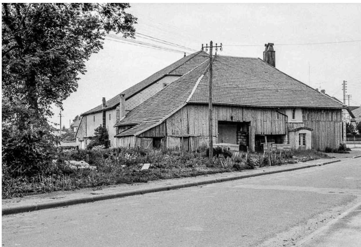
Ferme datée de 1797 : façade sur rue.
