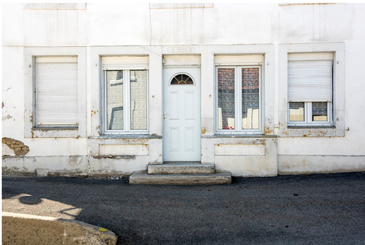
Façade antérieure : baies de l'étage de soubassement.
