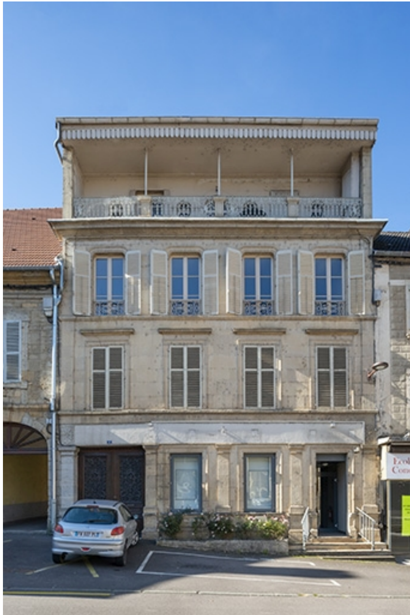
Façade de l'immeuble sur la rue.
