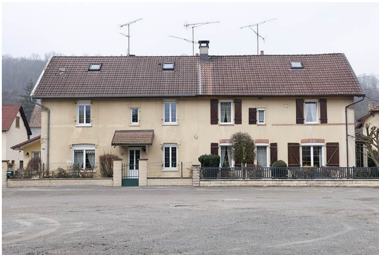
Immeuble à 4 logements. Façade est.
