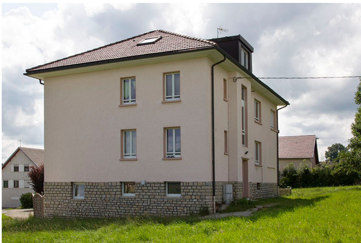
Façades latérale droite et postérieure.
