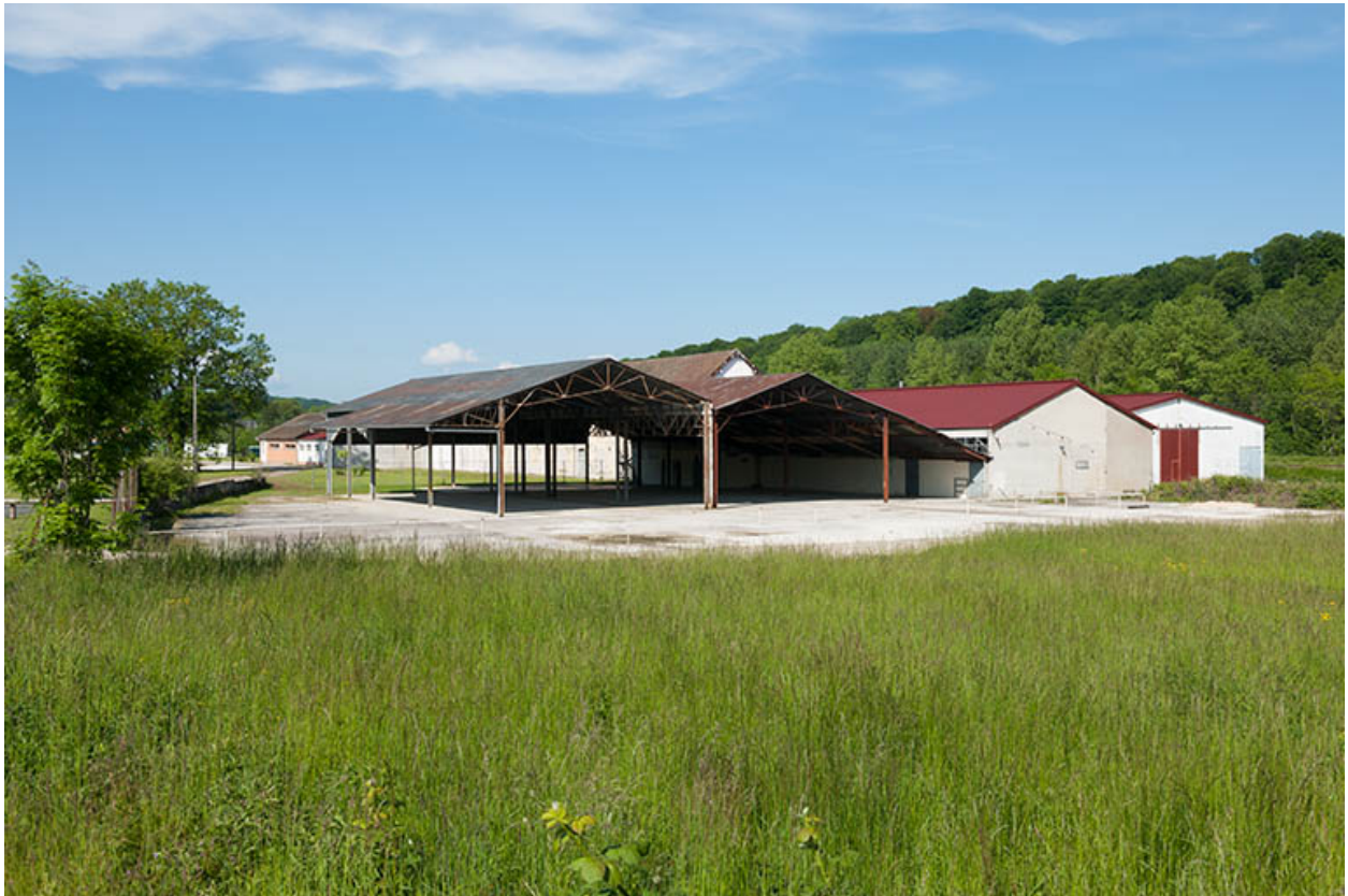
Entrepôt industriel et ateliers depuis l'est.
