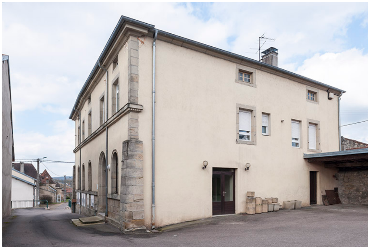
La façade postérieure.
