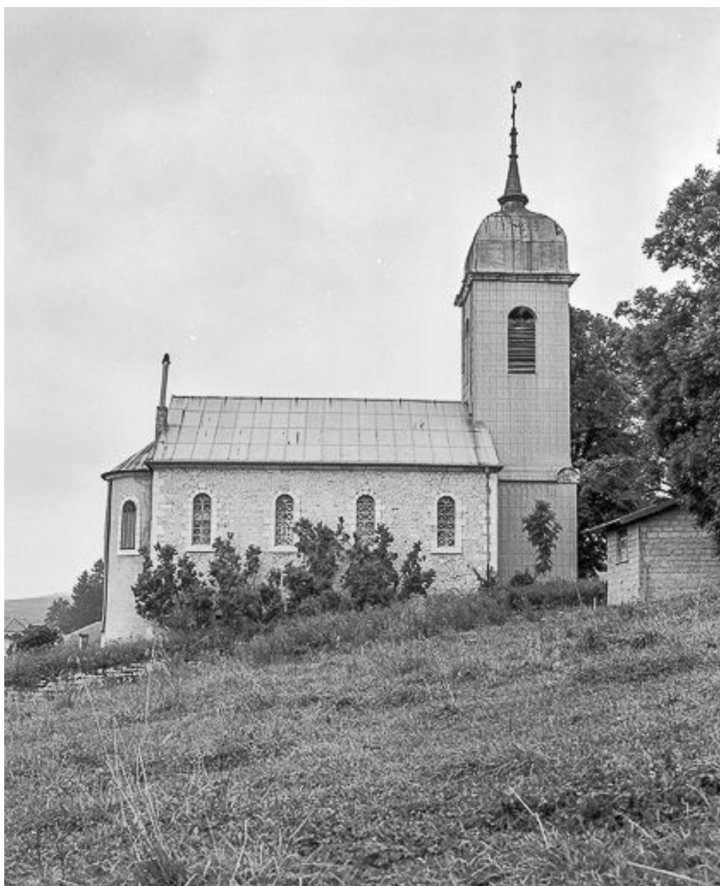
Façade latérale droite.
