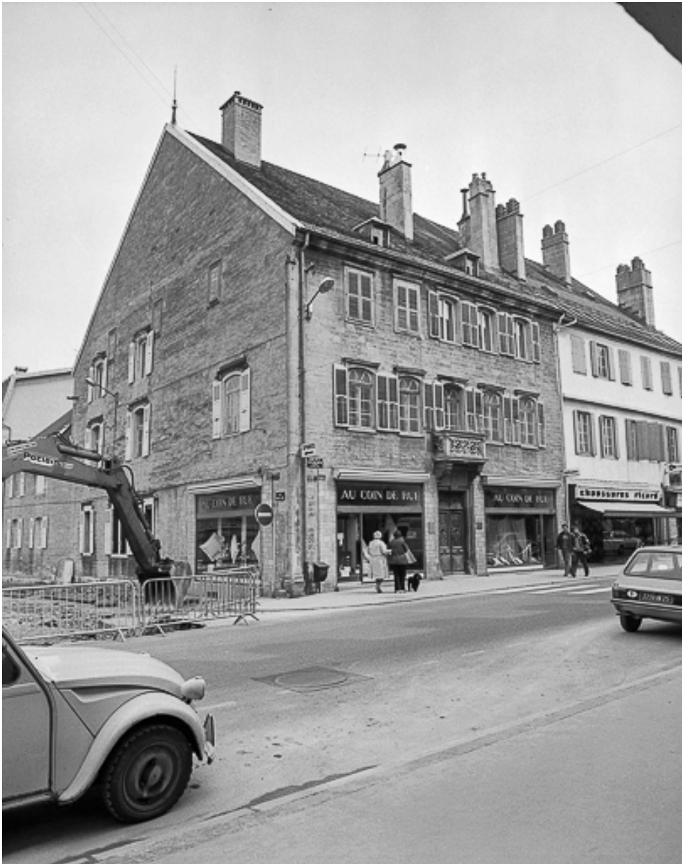
Façade sur rue.
