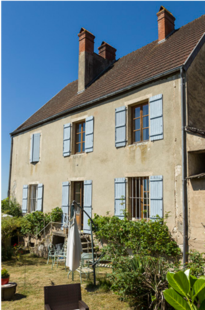
Façade postérieure du logis, côté jardin.
