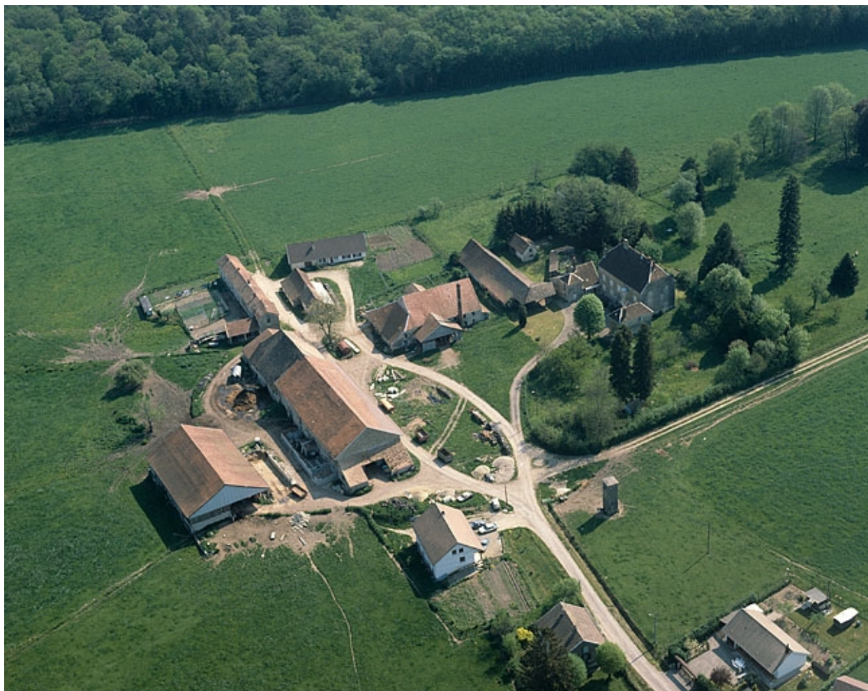
Vue aérienne depuis l'ouest.
