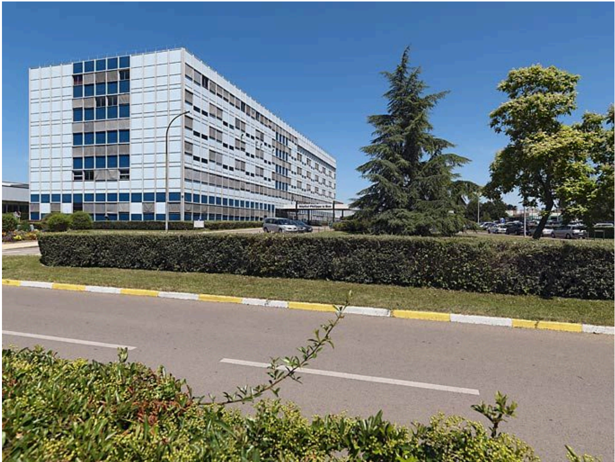
Bâtiment principal, vue d'ensemble de trois-quarts.
