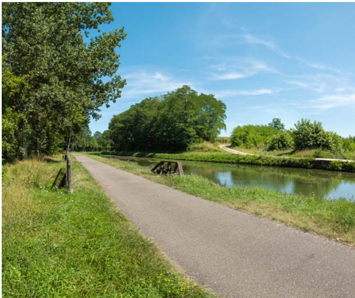
Vue de l'aqueduc.
