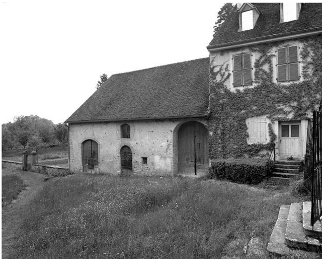
Façade antérieure du logis : partie gauche.
