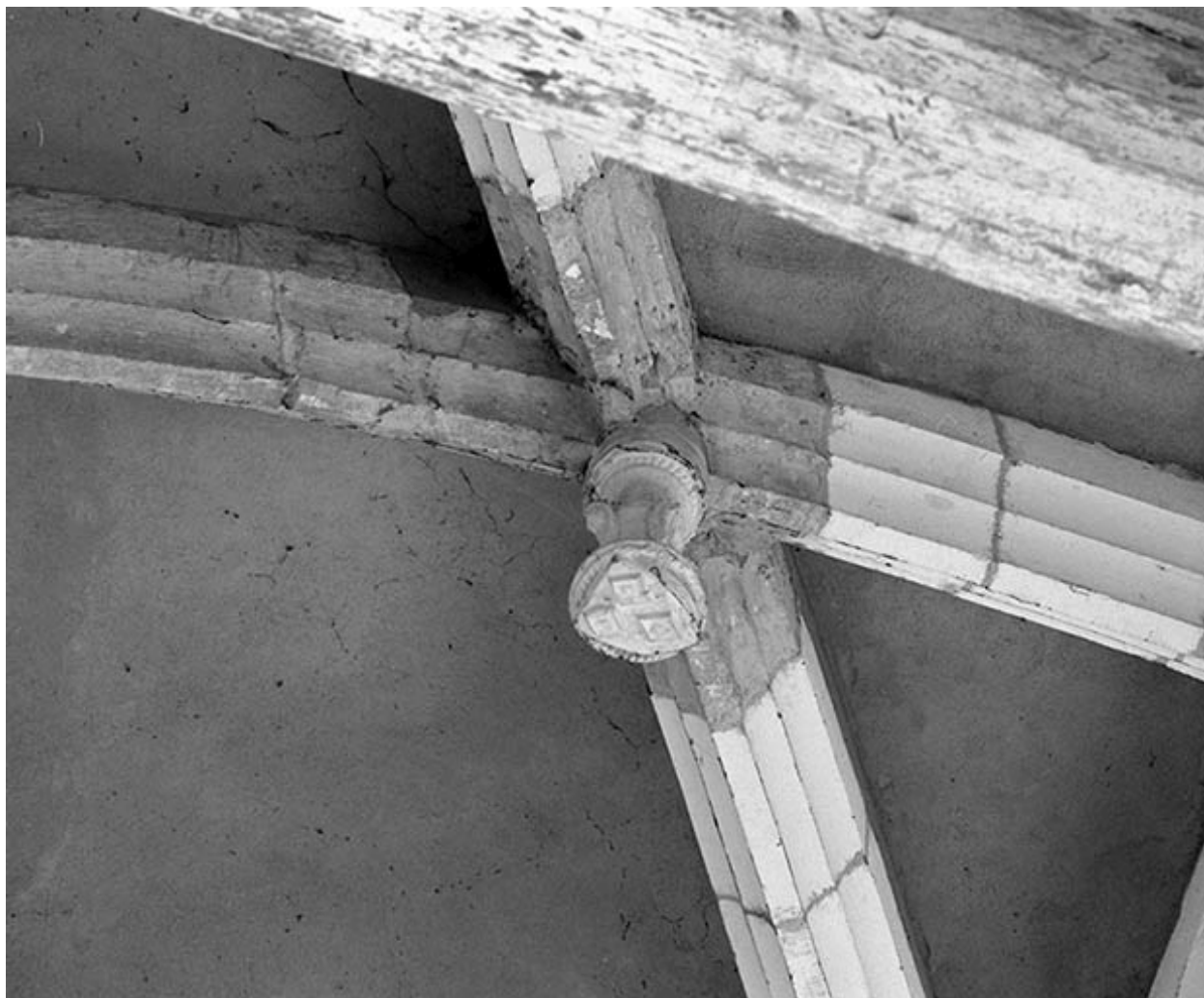
Choeur, détail : clef de voûte.
