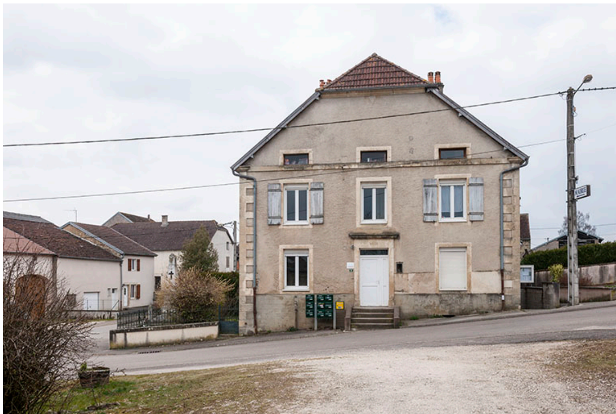
Vue sur la façade principale.
