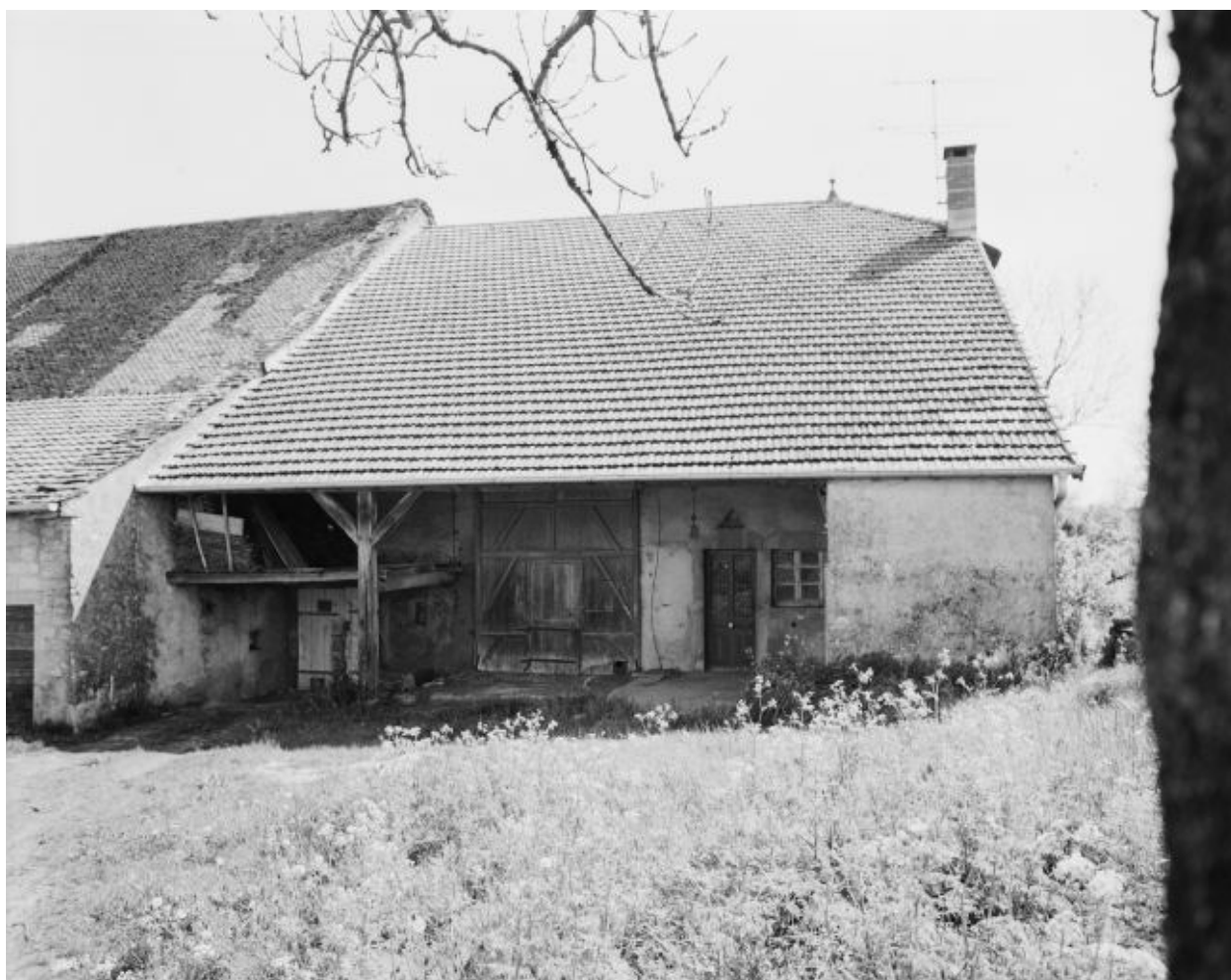
Ferme située rue des Sétrettes : façade antérieure.
