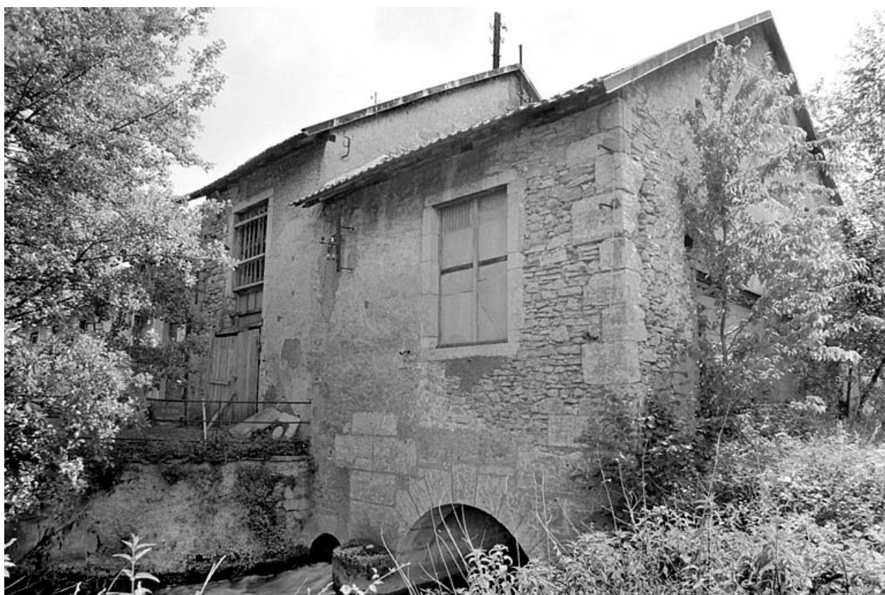
Salle des machines et bâtiment d'eau.
