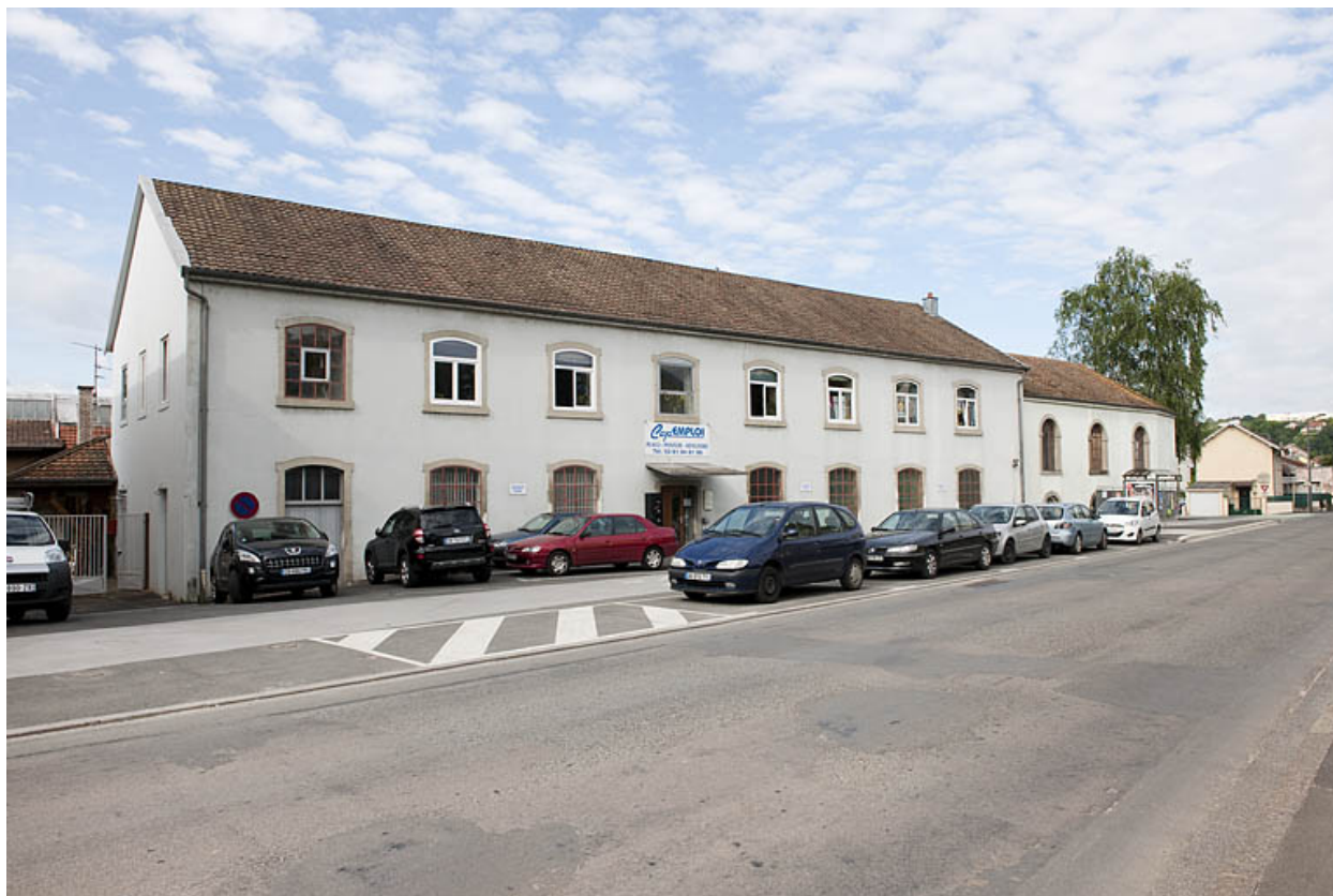
Bâtiment administratif (?) longeant le faubourg de Besançon.
