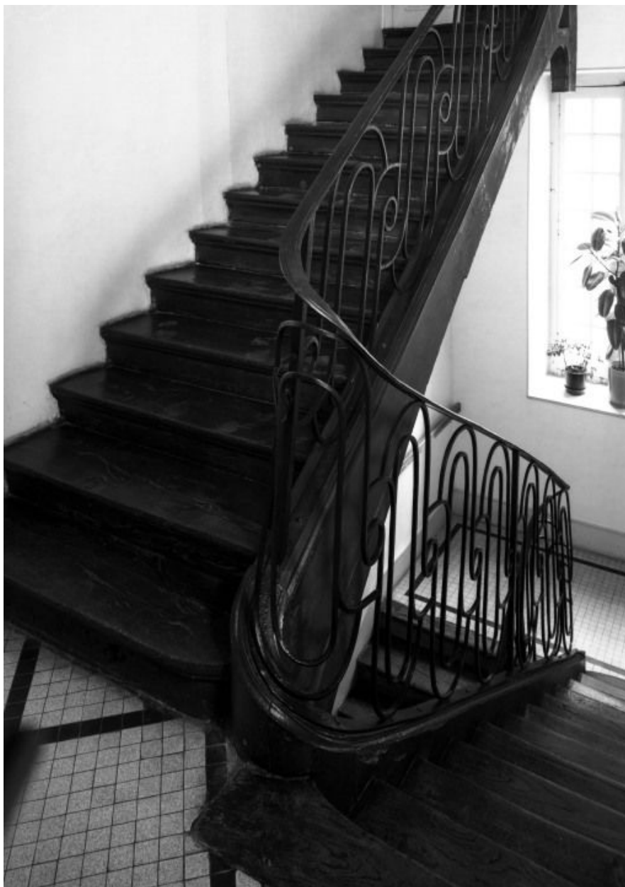
Escalier, deuxième et troisième volées.
