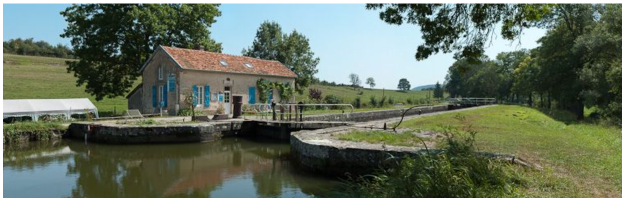
Vue du site d'écluse.
