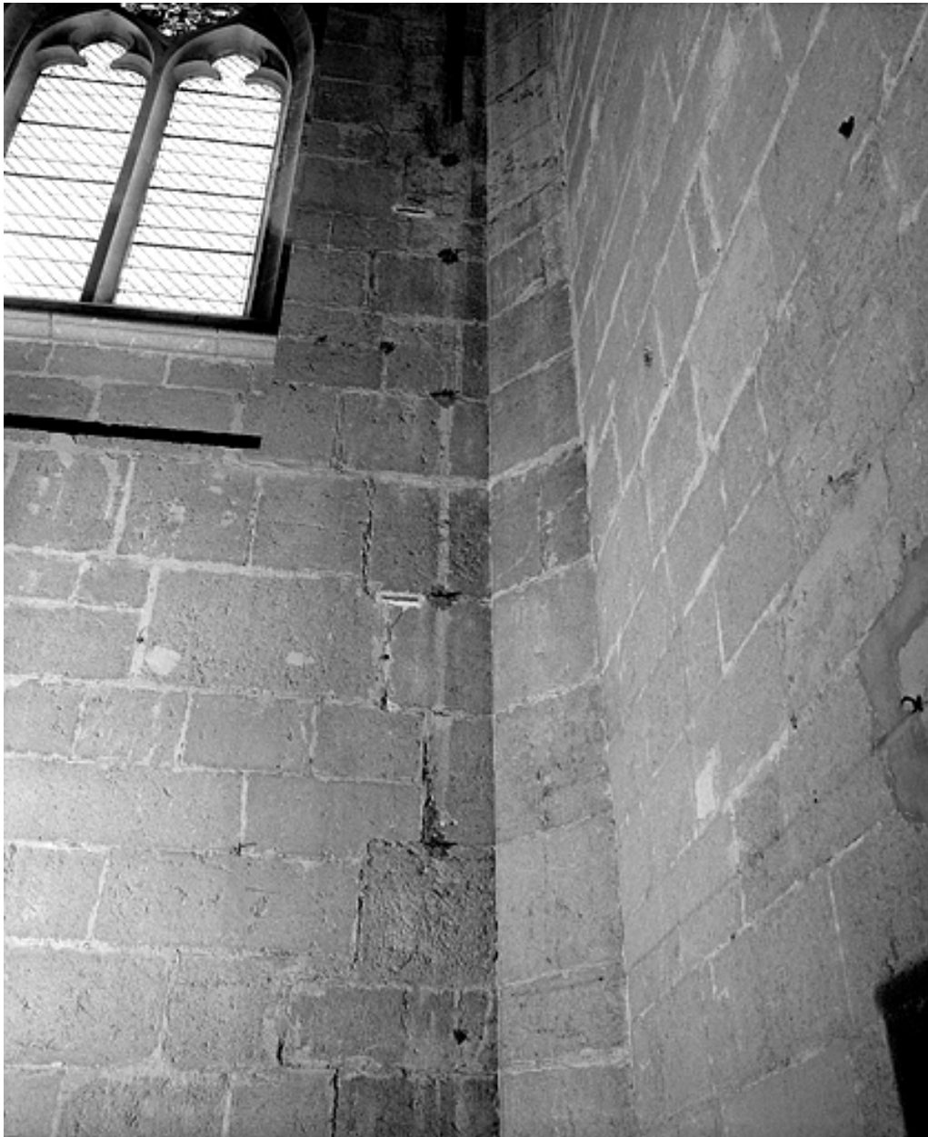
Détail du parement du collatéral nord : couture à hauteur de la huitième travée.
