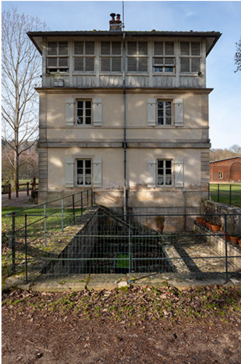
Façade sud-ouest avec le lavoir.
