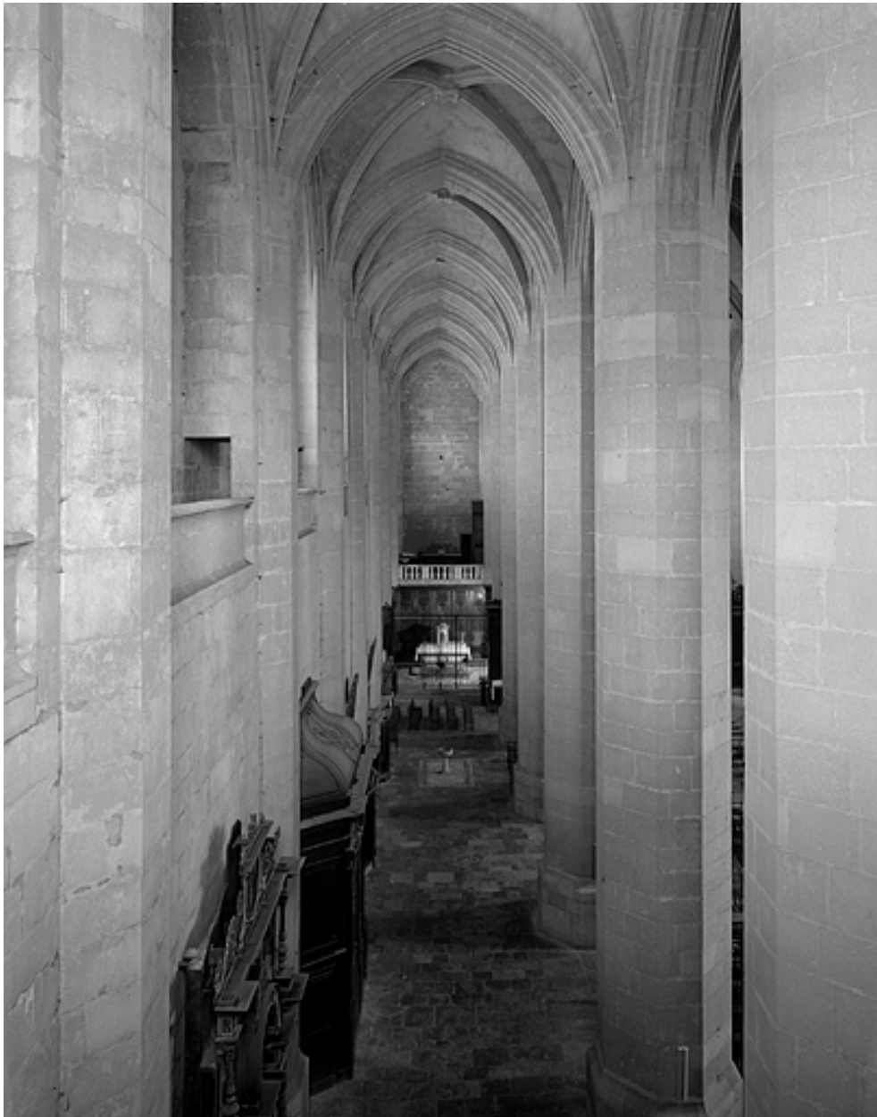
Vue du collatéral nord vers l'est depuis la coursière basse.
