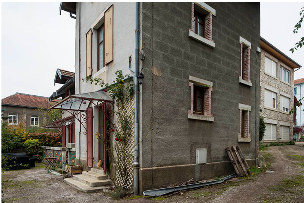
Logement, adossé au pignon sud de l'atelier.
