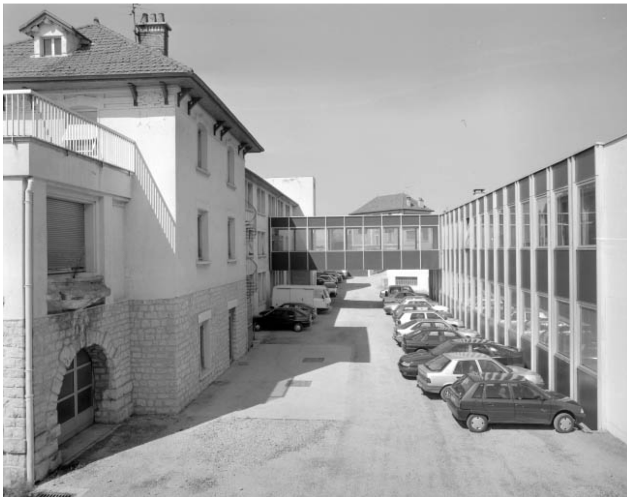
Ateliers de fabrication depuis le sud.
