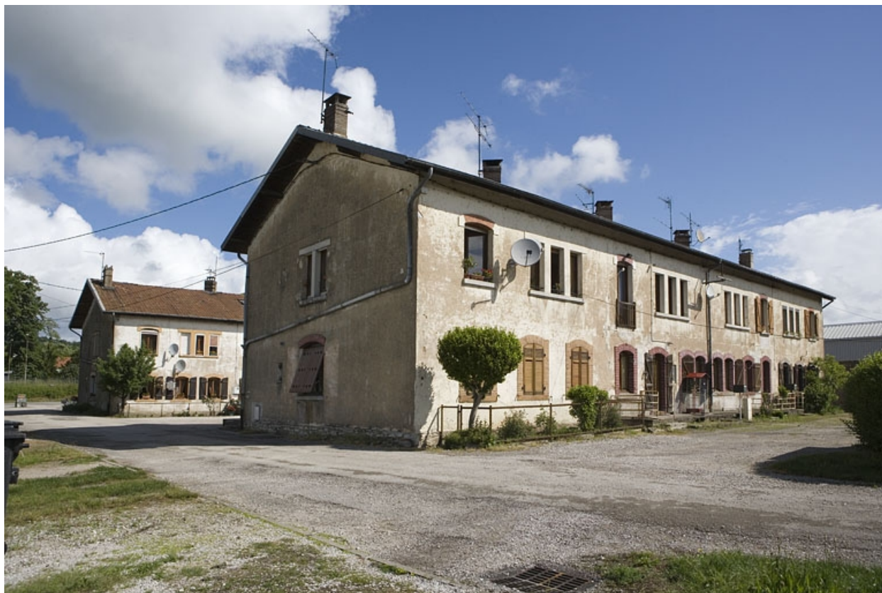
Cité ouvrière (rue Weibel). Vue rapprochée d'une façade postérieure.
