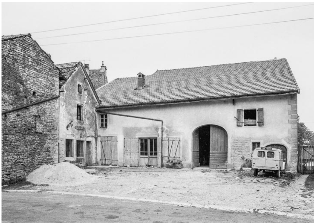
Ferme cadastrée 1951 E1 110 : façade antérieure.
