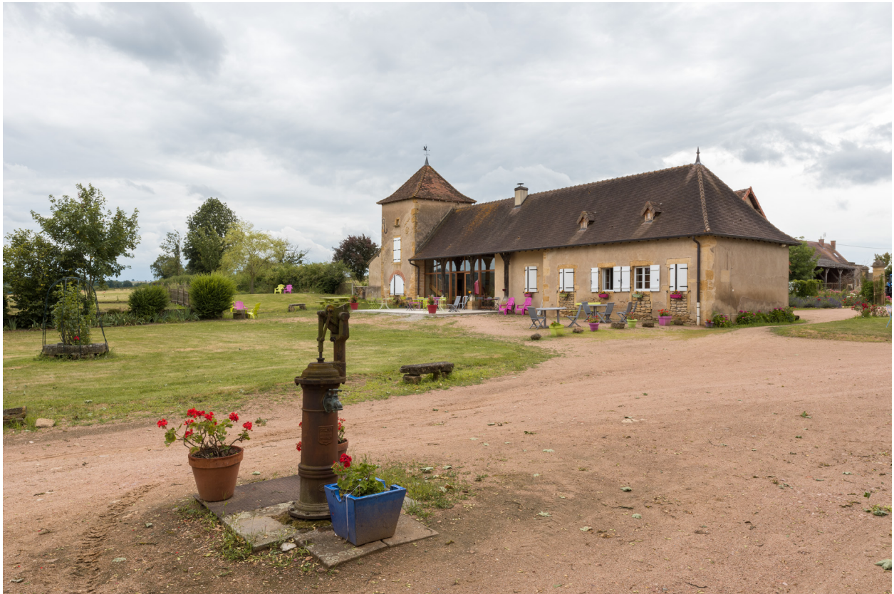
Remise et pigeonnier vus depuis le nord-est.
