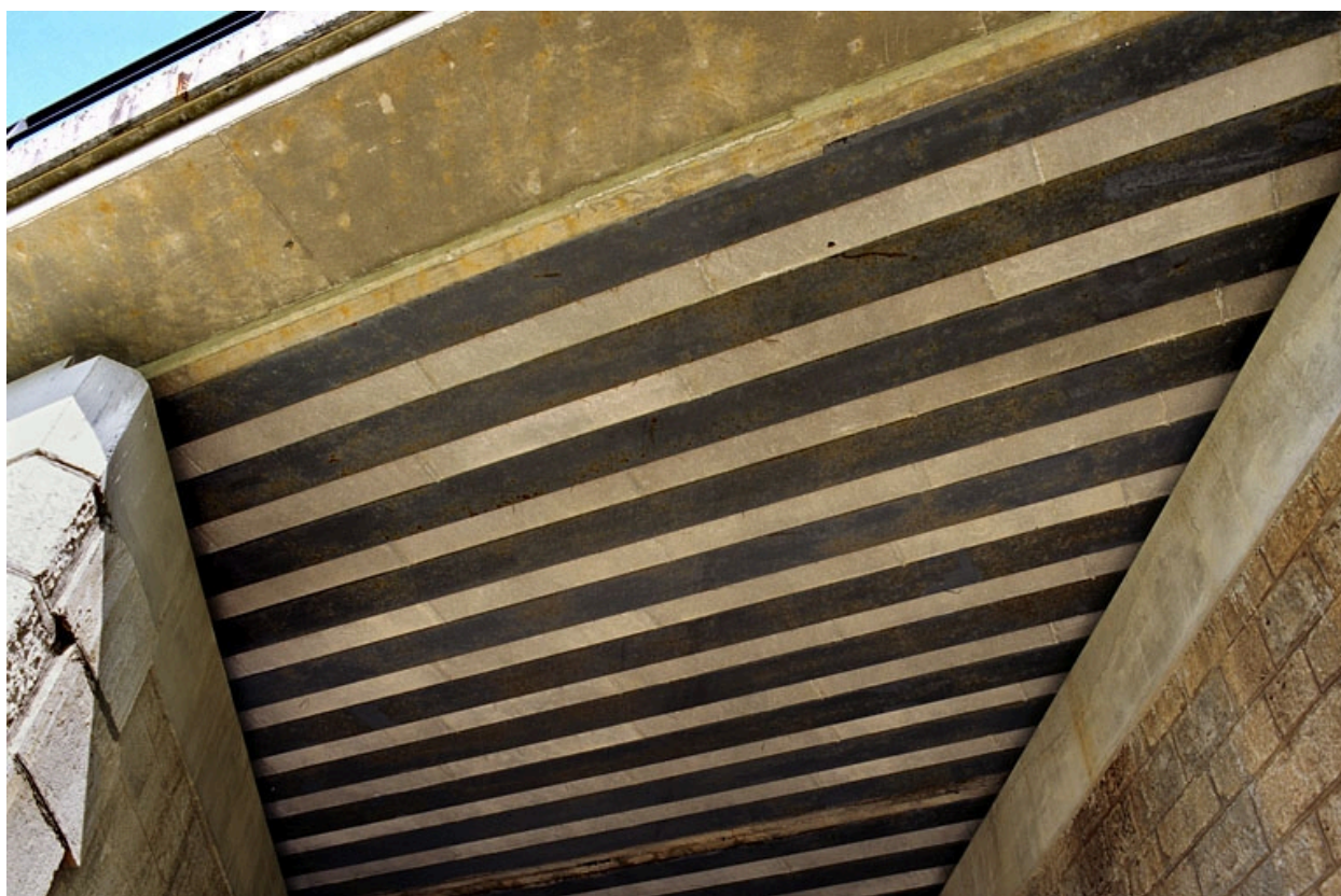
Face inférieure du tablier : poutrelles enrobées.
